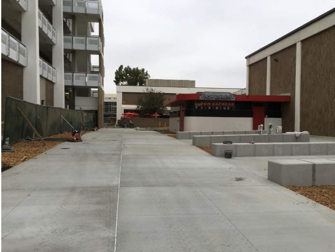
Concrete Pour by Don Express
